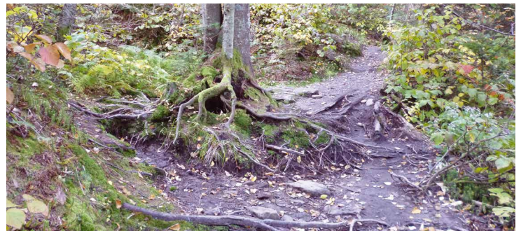
Les marcheurs évitant les passages boueux élargissent l'emprise du sentier et fragilisent la flore environnante pouvant entraîner la mort hâtive des arbres matures.
